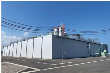
大分工場廃水処理設備
